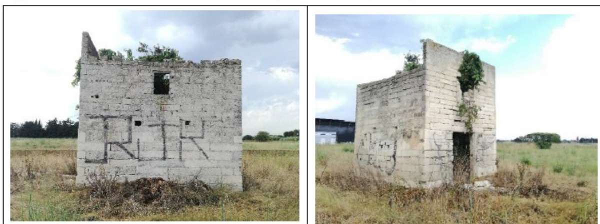
Etat actuel du bâtiment concerné par ce projet de réhabilitation pour l'Effraie des clochers et les chiroptères
