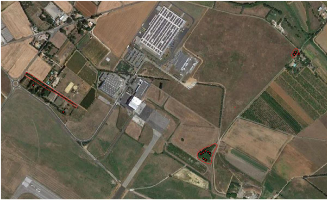
Localisation générale des zones et arbres d'intérêt écologique à baliser sur site
